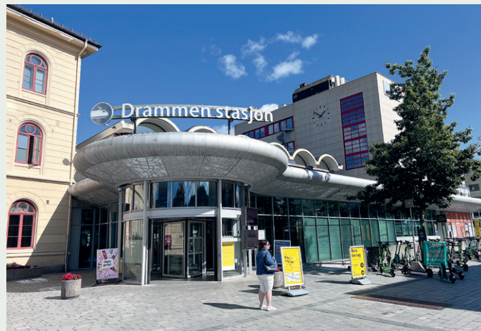
Det er ikke gjort store arbeider ved hovedinngangen, men deler av stasjonshallen er ny.
