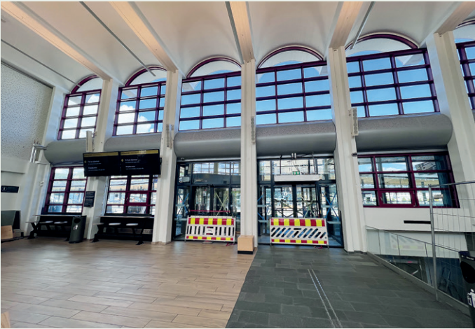
Deler av stasjonshallen er fornyet.
