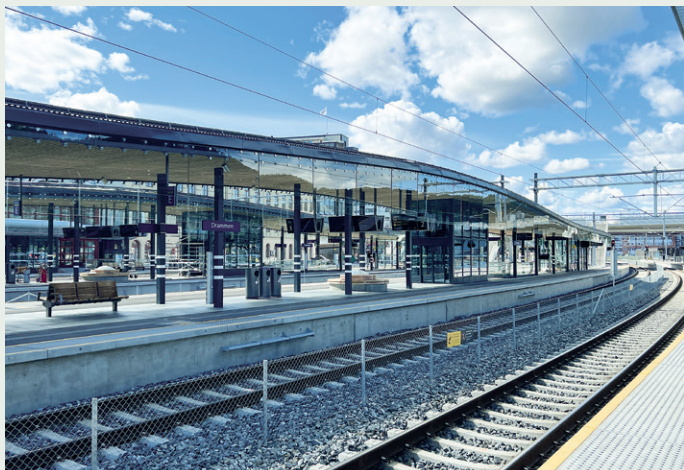
Hele stasjonsområdet hevet 40 centimeter for å være bedre rustet mot flom.
