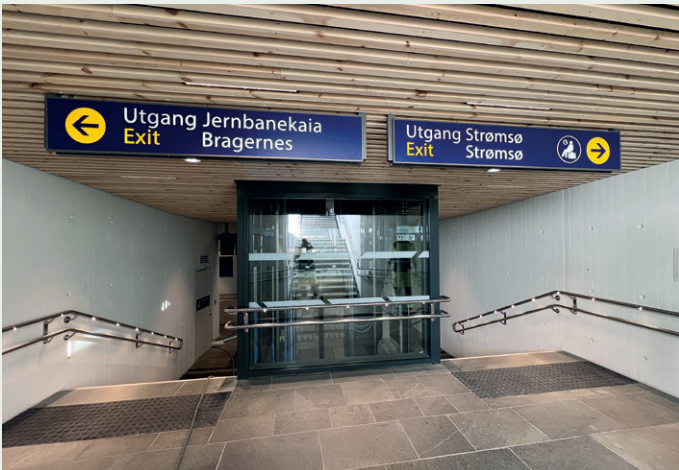
Det er gjort store arbeider både under og over bakken.
