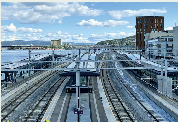
Det er lagt solceller på store deler av stasjonsoverbyggene.
