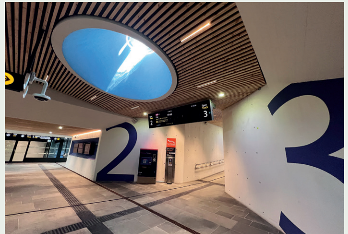
Det er bygget en ny undergang fra stasjonshallen under sporene.
